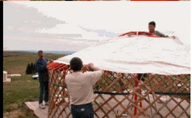
7 Une personne doit rester au centre de la yourte pour soutenir le pilier central afin que les baguettes ne tombent pas
